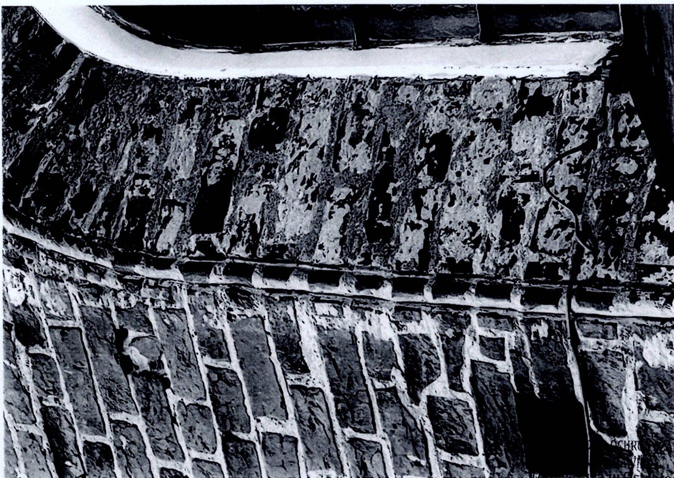
Fot. 47 Przasnysz. Kościół par. p.w. Wniebowzięcia NMP – fragment wtku ceglanego
