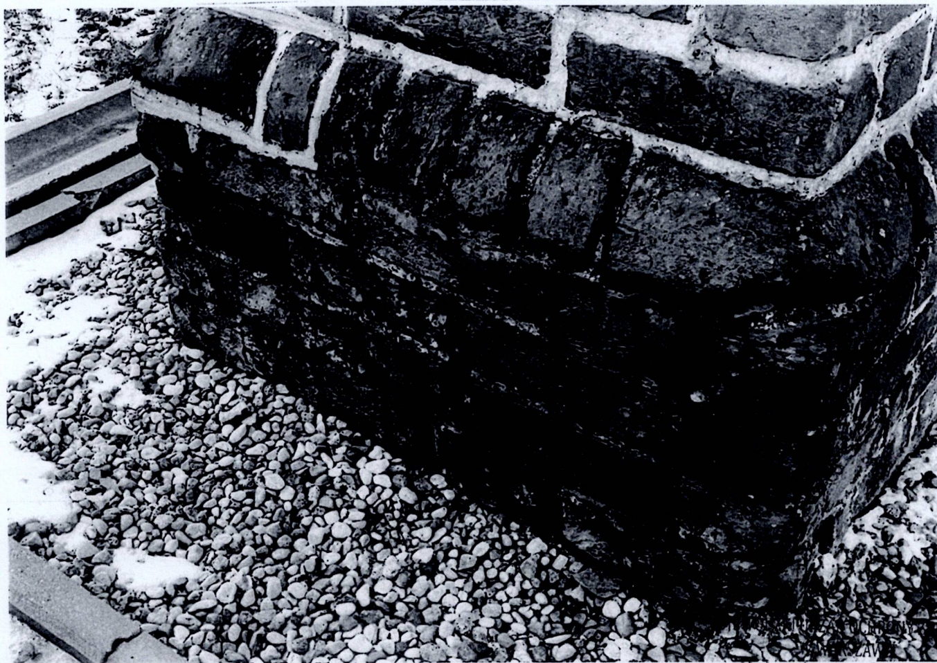
Fot. 36 Przasnysz. Kościół par. p.w. Wniebowzięcia NMP – fragment cokołu
