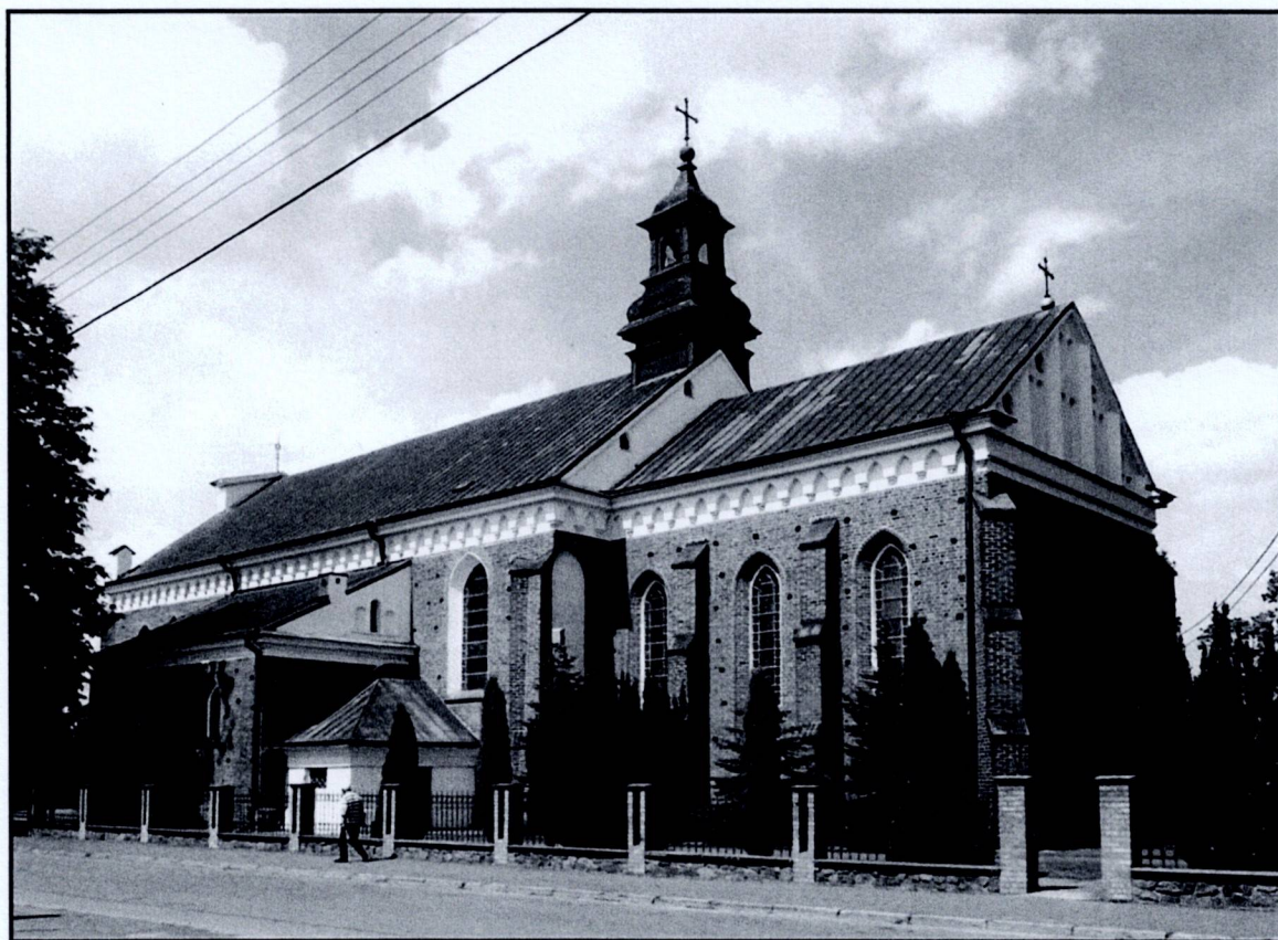
2. Kościół parafialny w Przasnyszu – widok od południowego-wschodu. Fot. M. Koszarski
