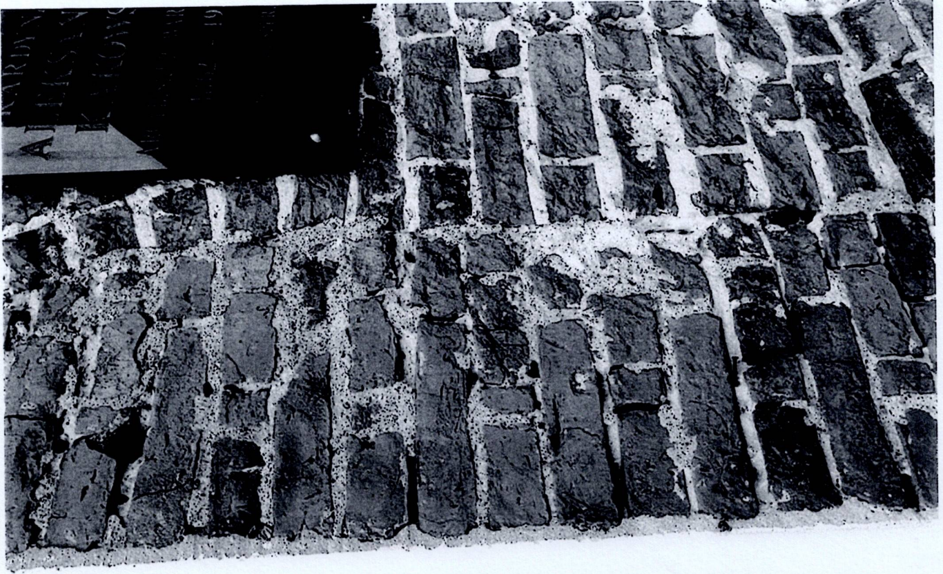
Fot. 44 Przasnysz. Kościół par. p.w. Wniebowzięcia NMP — fragment wstępu ceglanoego
