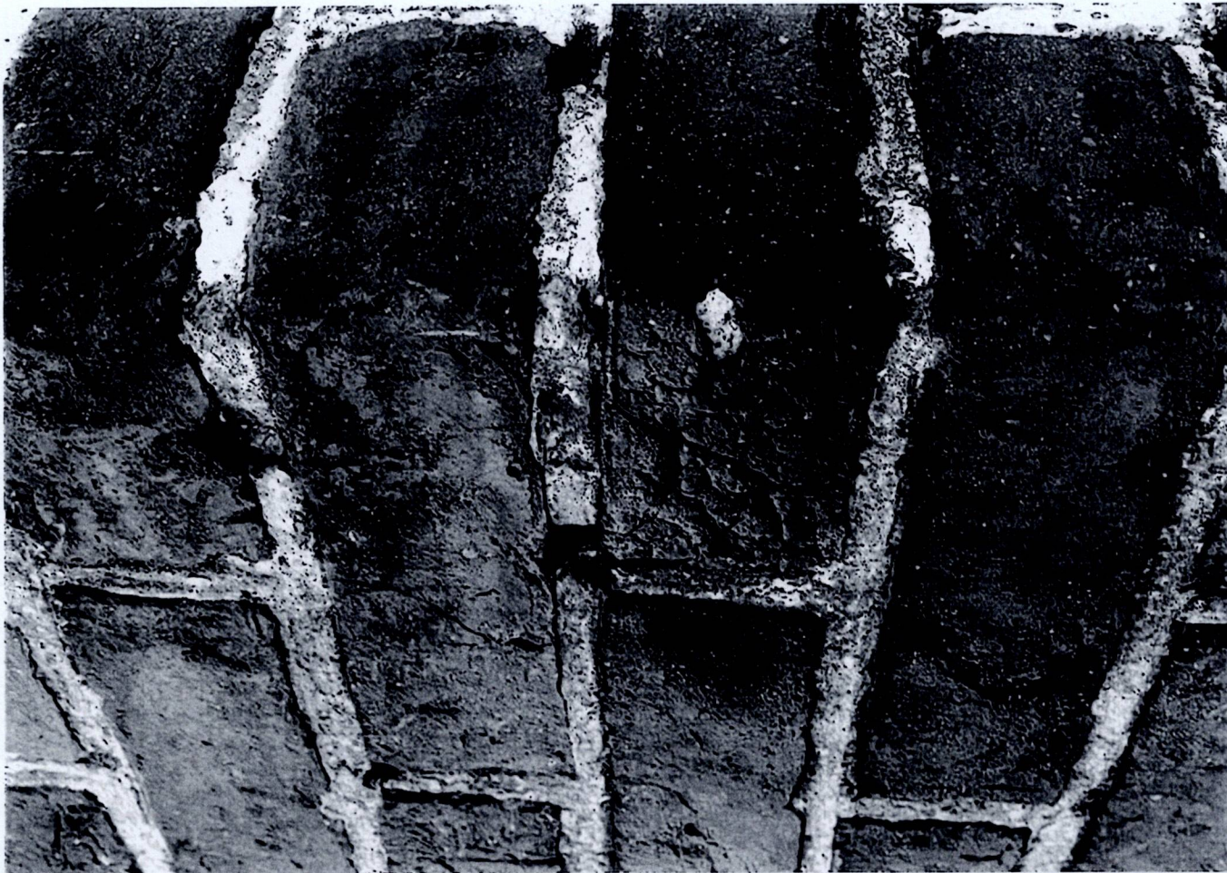
Fot. 52 Przasnysz. Kościół par. p.w. Wniebowzięcia NMP – fragment wstępu ceglanoego
