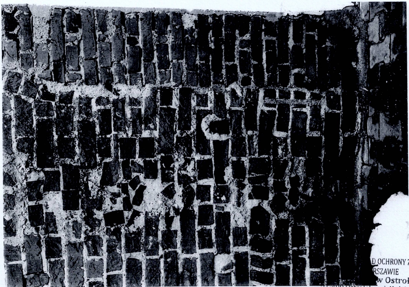
Fot. 43 Przasnysz. Kościół par. p.w. Wniebowzięcia NMP — fragment wstępu ceglanoego
