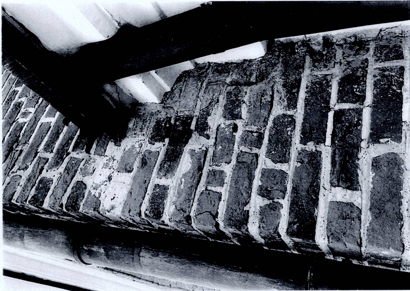
Fot. 32 Przasnysz. Kościół par. p.w. Wniebowzięcia NMP – fragment ścian
