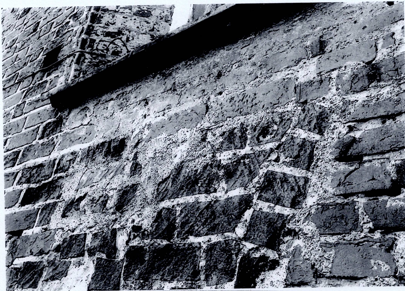
Fot. 41 Przasnysz. Kościół par. p.w. Wniebowzięcia NMP – fragment wątku ceglano
