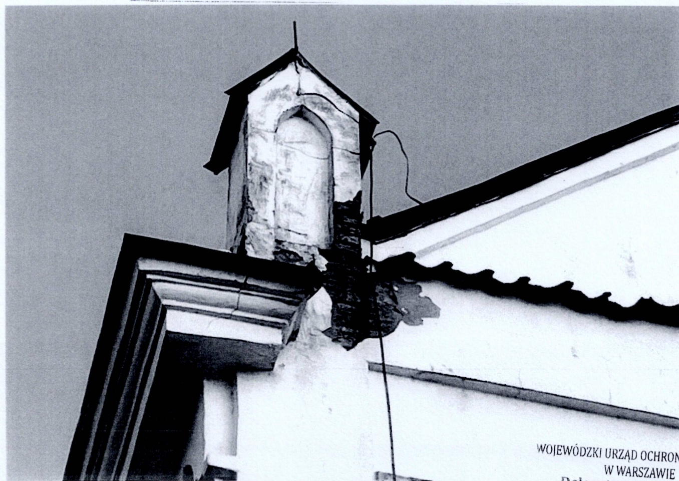
Fot. 18 Przasnysz. Kościół par. p.w. Wniebowzięcia NMP – fragment ściany zach.
