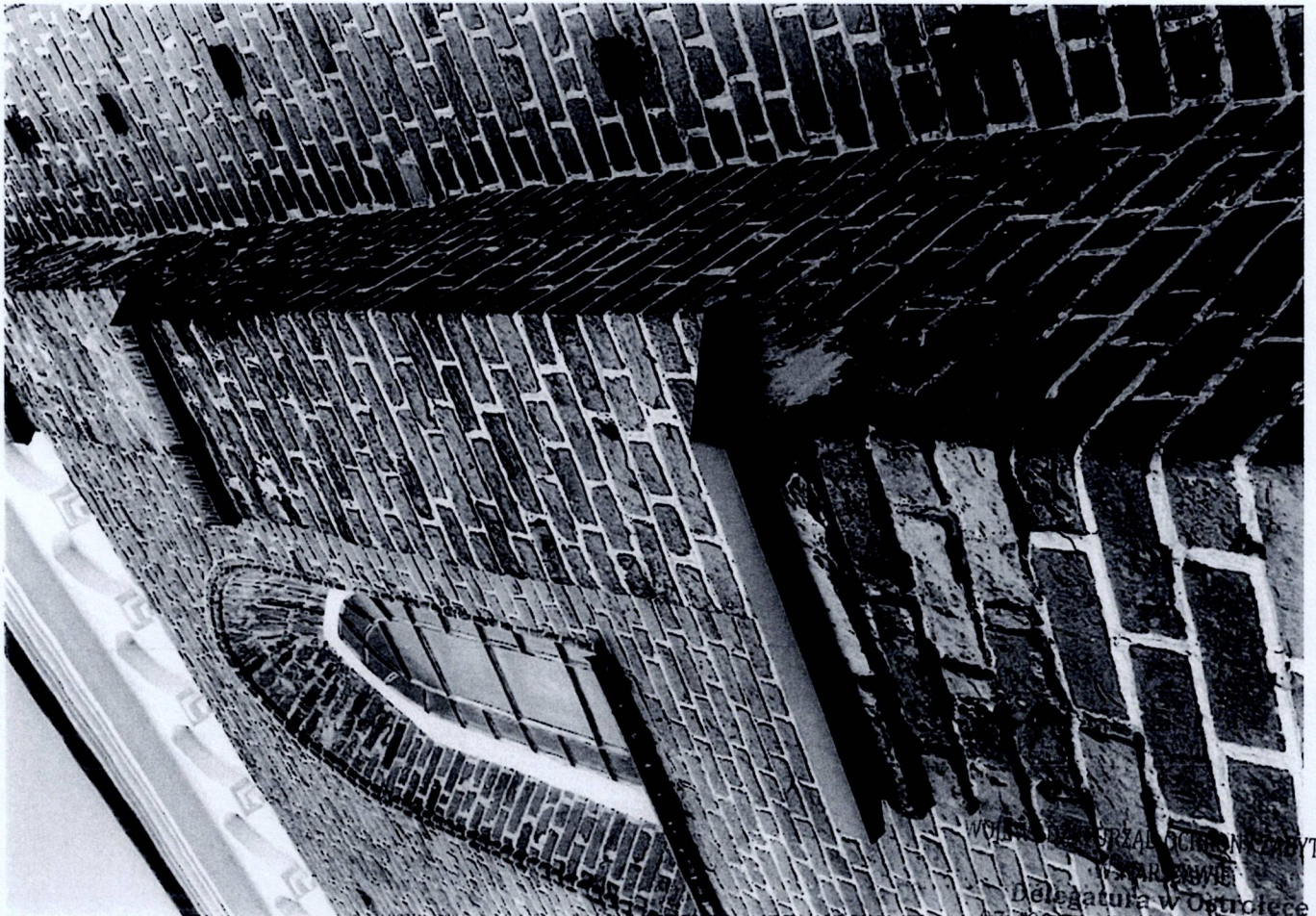
Fot. 29 Przasnysz. Kościół par. p.w. Wniebowzięcia NMP
