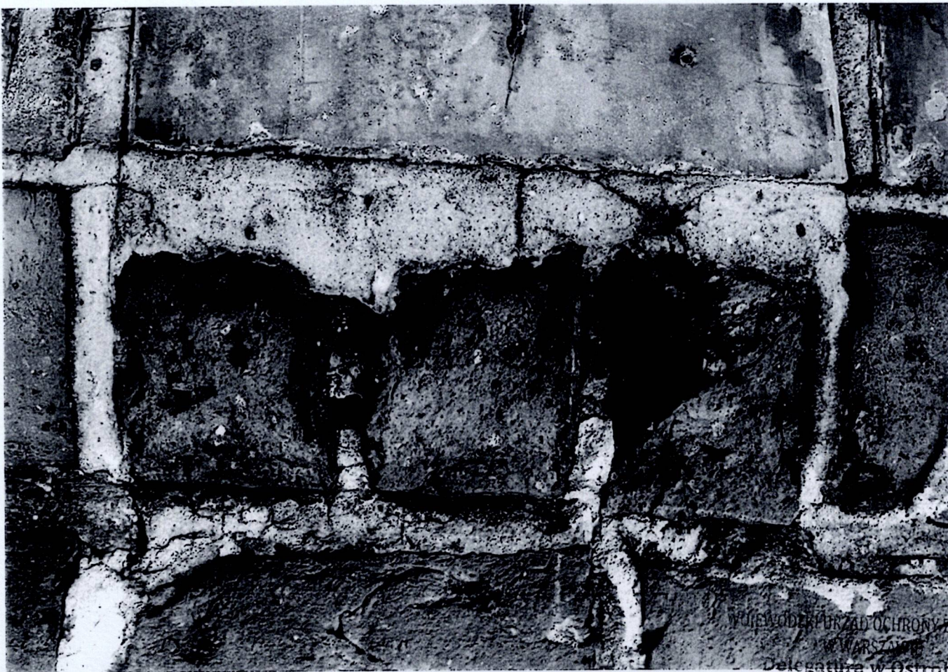
Fot. 51 Przasnysz. Kościół par. p.w. Wniebowzięcia NMP – fragment wstępu ceglanoego
