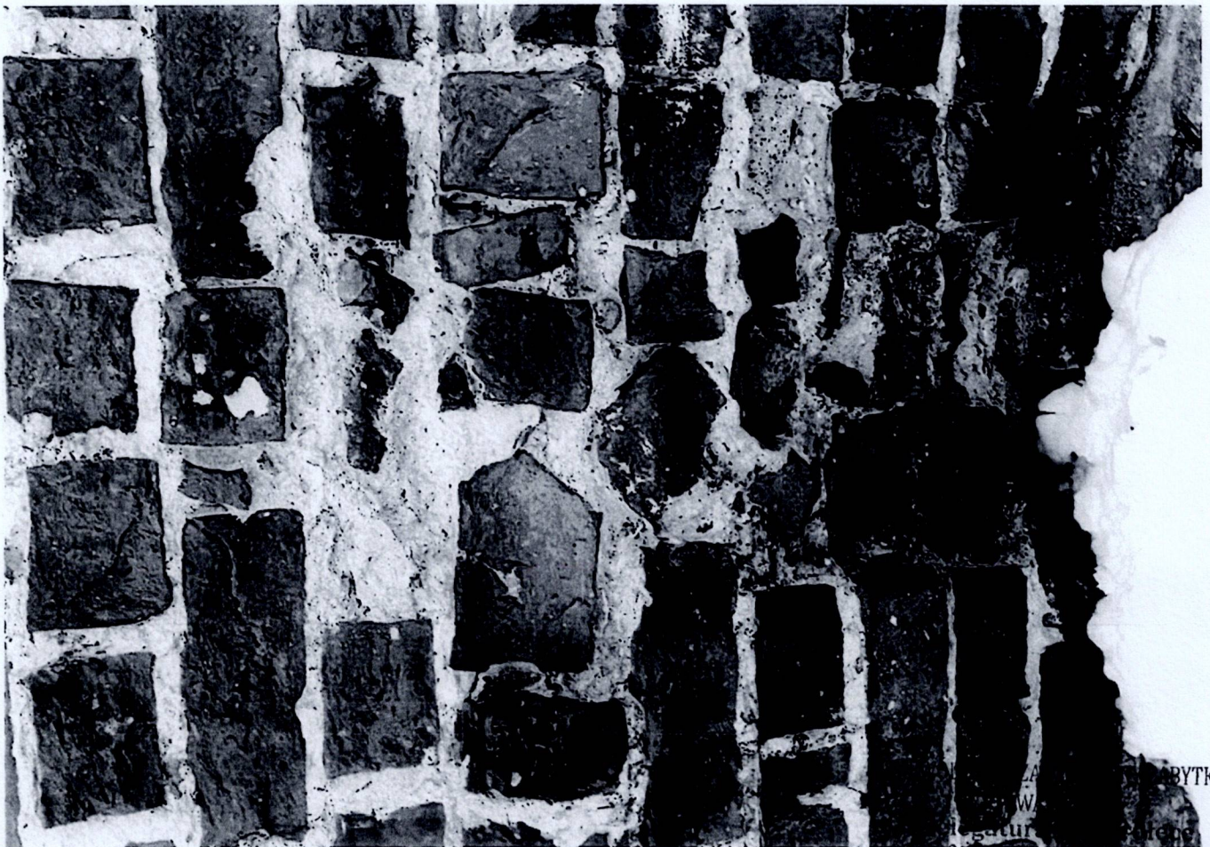
Fot. 45 Przasnysz. Kościół par. p.w. Wniebowzięcia NMP
