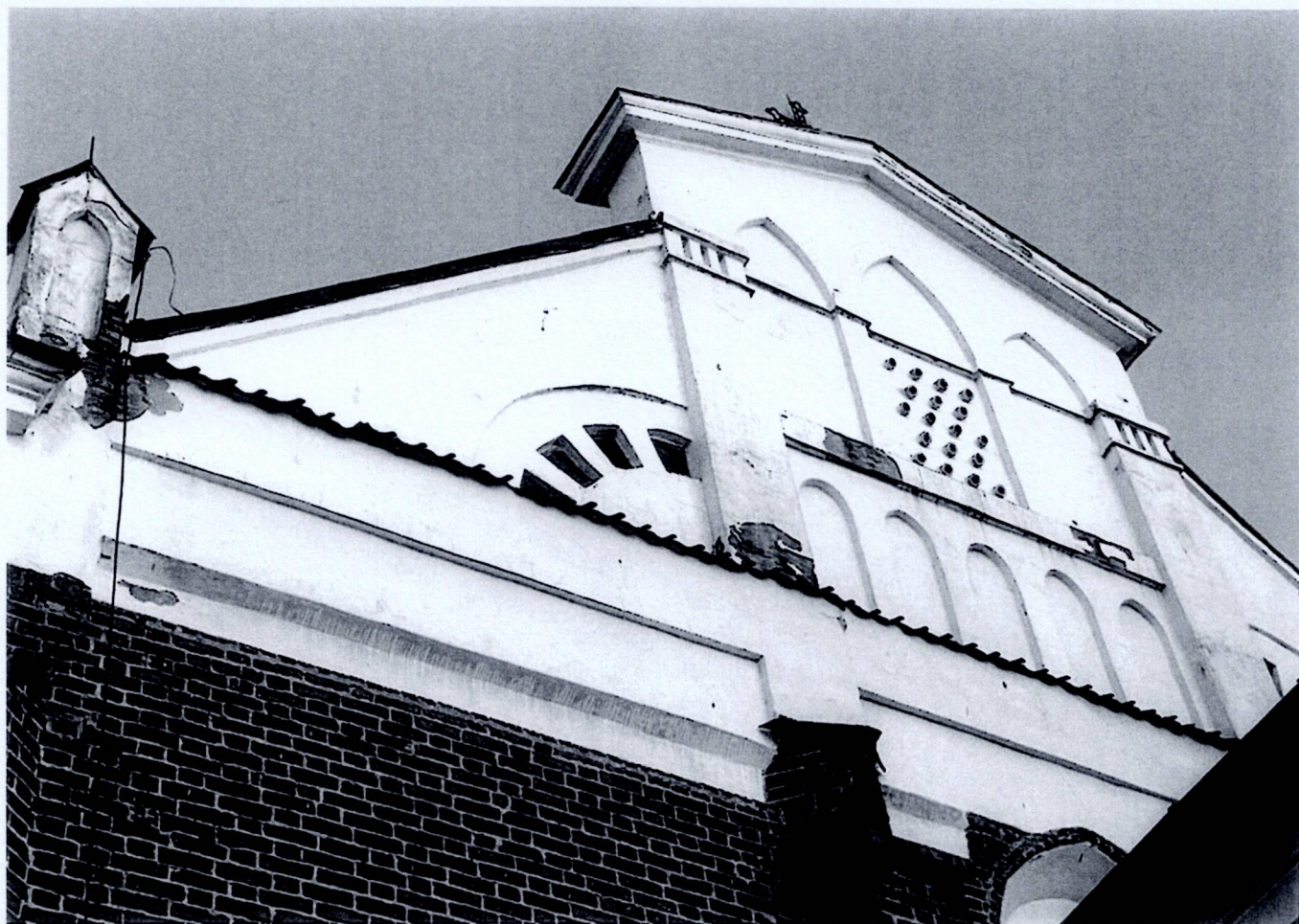
Fot. 17 Przasnysz. Kościół par. p.w. Wniebowzięcia NMP – fragment ściany zach.
