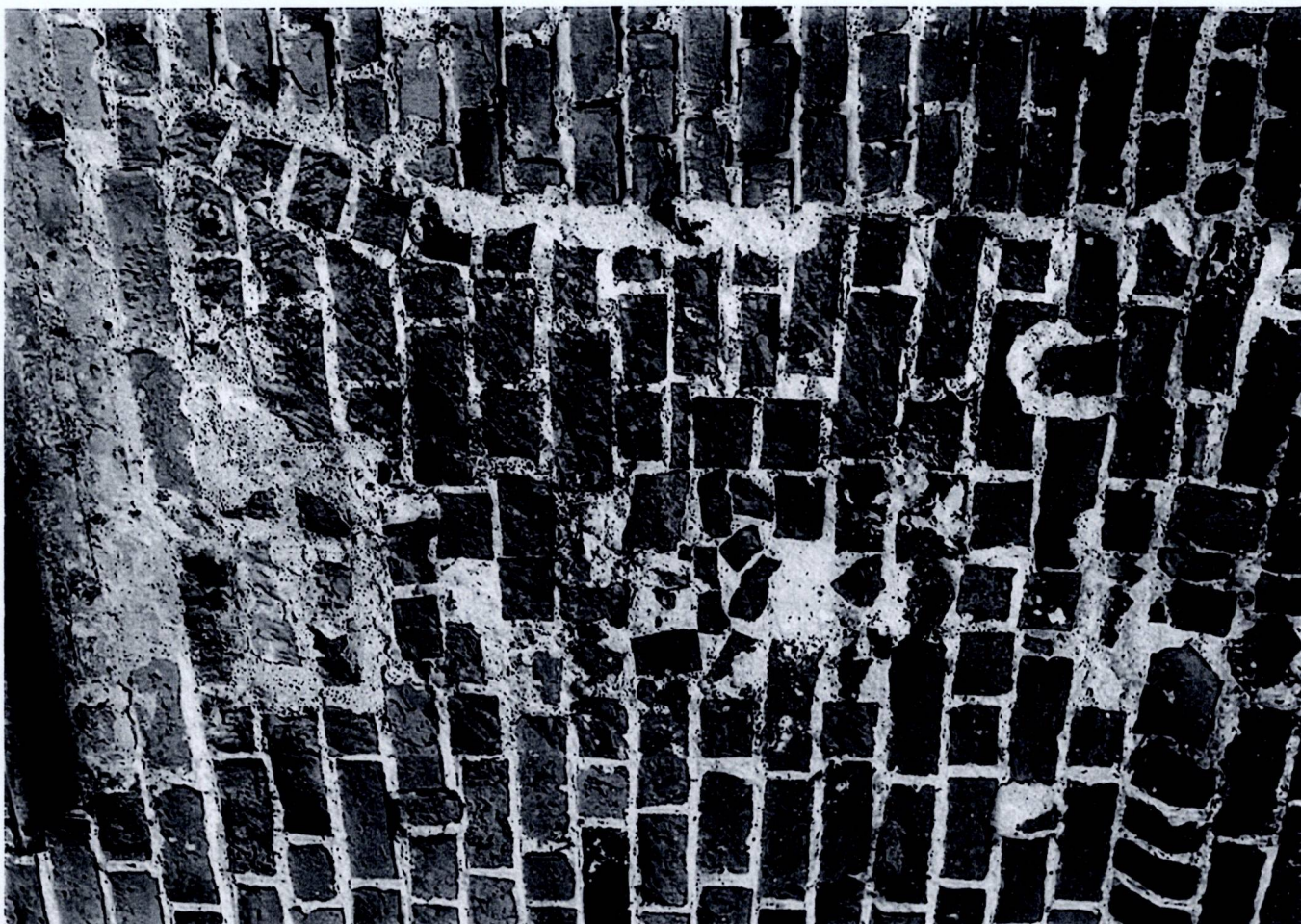
Fot. 48 Przasnysz. Kościół par. p.w. Wniebowzięcia NMP – fragment wtku ceglanego
