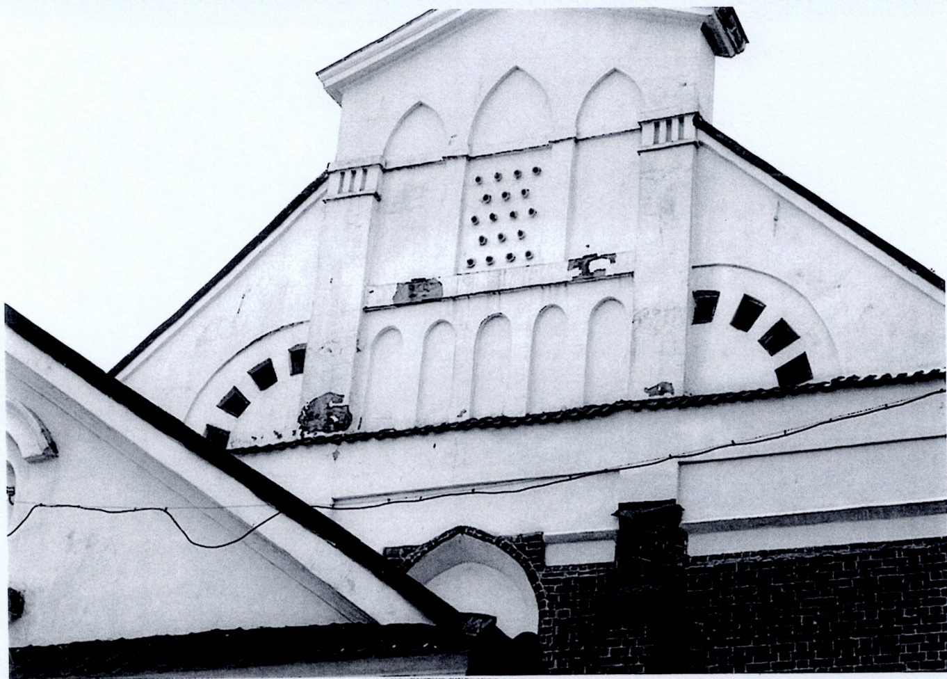
Fot. 19 Przasnysz. Kościół par. p.w. Wniebowzięcia NMP – fragment ściany zach.
