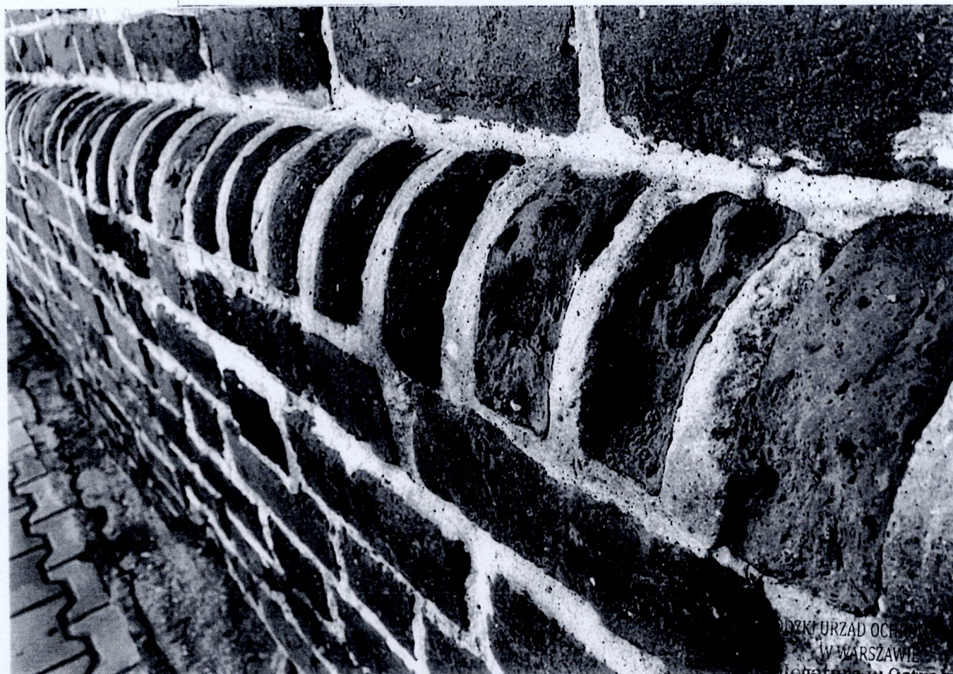
Fot. 42 Przasnysz. Kościół par. p.w. Wniebowzięcia NMP – fragment wątku ceglano
